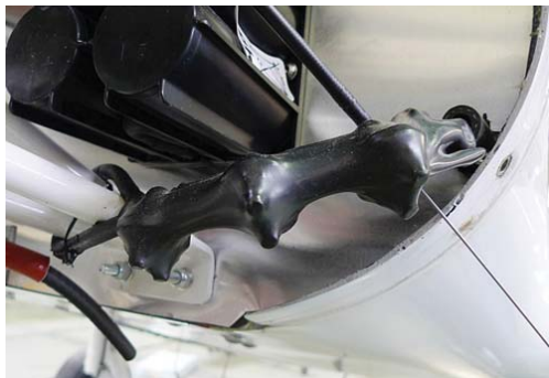
engine compartement / vano motore
